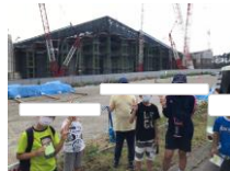
(ファイターズ工事現場)
